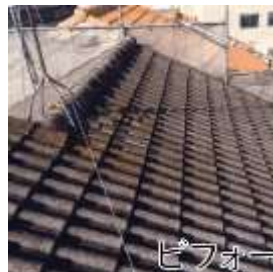
施工前（屋根 | 築12年）
