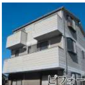
施工前（外壁 | 築15年）
